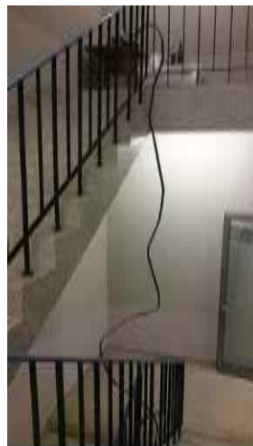
(사진3 : 내부 전경)
